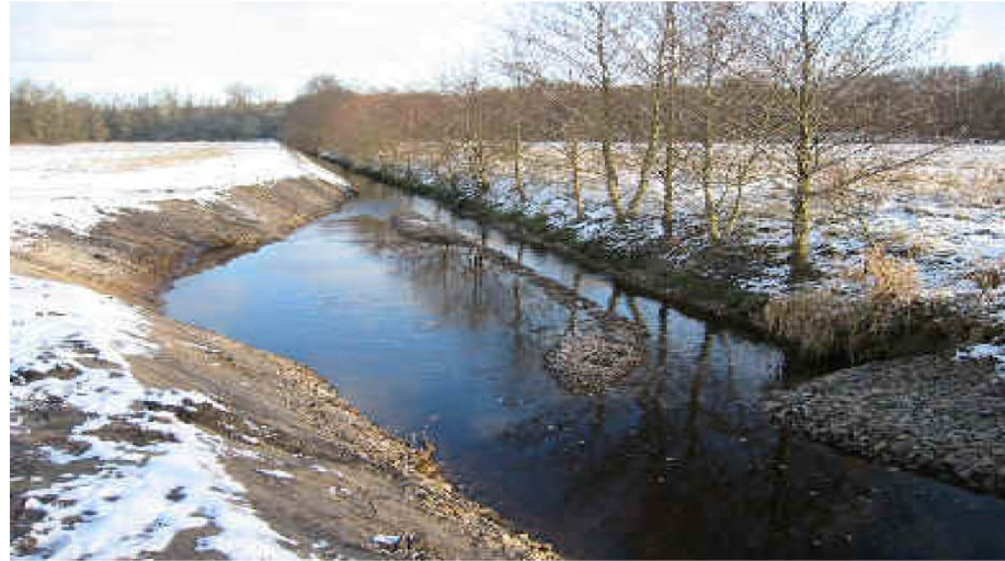
Abb. 6.3 Umsetzungsbeispiel Sandfang mit parallelem Fließgerinne; Quelle: infoNet Umwelt (2005)
