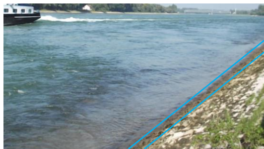
Foto 13: Vor dem Schiff entsteht ein Sog, der zu einer Wasserspiegelabsenkung führt (blaue Linien). Nach dem Schiff folgt der Schwall, der wellenartig auf das Ufer trifft. Anschließend normalisiert sich der Wasserspiegel nach und nach wieder. (Foto: STOWASSERPLAN)
