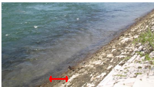
Foto 14: Sog und Schwall gehen mit hohen Schleppspannungen einher (Bereich roter Pfeil) und erfordern zur Gewährleistung der Schiffbarkeit daher meist eine Ufer- und Sohlensicherung. (Foto: STOWASSERPLAN)
