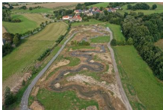
Foto 6: Gleicher Blickwinkel während der Bauausführung (08/2023): die Lage des renaturierten Verlaufes wurde auf Grundlage des im Gelände noch nachvollziehbaren historischen Verlaufes festgelegt. (Foto: STOWASSERPLAN)
