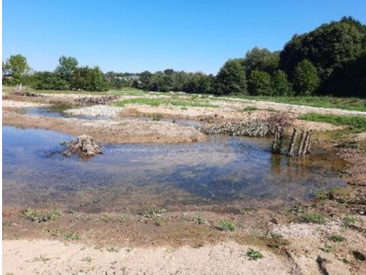
Foto 7: Entlang der Lauflinie wurde ein ausgesprochen flaches und strukturreiches Gewässerbett vorprofiliert, die Ausdifferenzierung der Habitatstrukturen erfolgt über die Eigendynamik des Gewässers. (Foto: STOWASSERPLAN)
