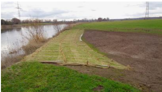
Foto 15: Einbau von Erosionsschutzmatten zum Schutz des Anschlussgrabens vor rückschreitender Erosion. (Quelle: WSV, Januar 2019)
