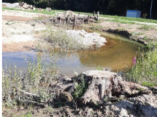
Foto 8: Ingenieurbiologische Bauweisen wurden nur punktuell zur Gewässerstrukturierung und Initiierung von Eigendynamik eingesetzt: vorn im Bild Wurzelstüben, im Hintergrund Totholzpackung als Abweiser. (Foto: STOWASSERPLAN)
