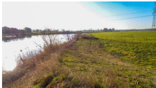
Foto 16: Das angewachsene Saatgut stabilisiert die Erosionsschutzmatten, die innerhalb von wenigen Jahren vollständig verrotten. (Quelle: WSV, Januar 2020)
