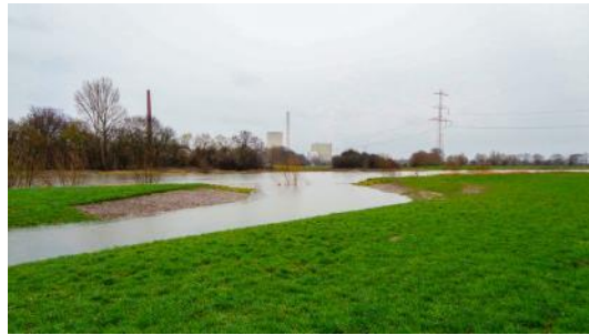
Foto 14: Südliche Flutrinne nach Maßnahmenumsetzung. Bei einem Wasserabfluss etwas oberhalb von Mittelwasser strömt das Wasser der Weser durch den geschaffenen Anschluss in die Flutrinnen. (Quelle: WSV, März 2019)
