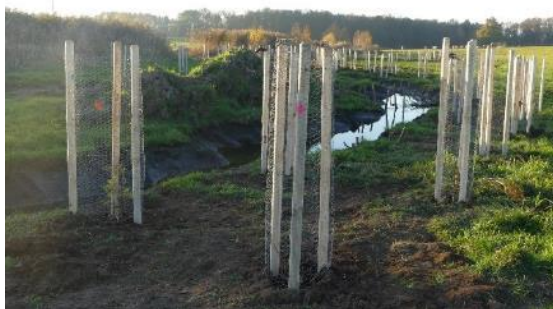
Foto 34: Einzelgehölzpflanzungen auf dem Gewässervorland sind aufwändiger in der Herstellung, insbesondere dann, wenn jedes Gehölz mit einem Verbisschutz versehen werden muss. (Foto: STOWASSERPLAN)
