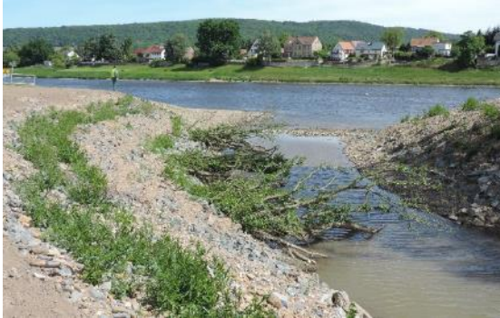
Foto 36: Die Ufersicherung des Seitenarmes wurde nur in Teilbereichen vorgenommen und vorrangig mit ingenieurb biologischen Bauweisen (Buschlagen und Lebende-Abweiser) ausgeführt. Bei Niedrigwasser verhindert eine Sohlschwelle das Leerlaufen des Seitenarmes. (Foto: STOWASSERPLAN)
