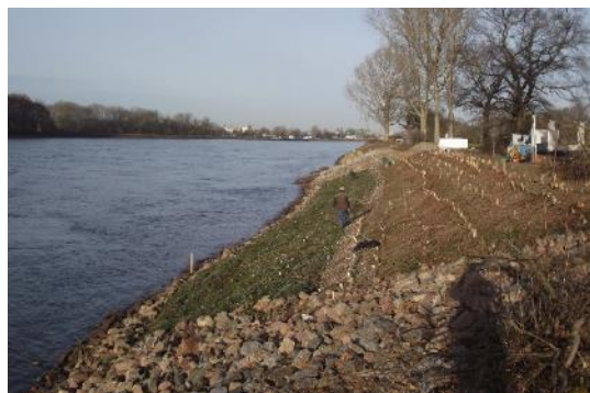
Foto 10: Es können auch verschiedene ingenieurbioologische Bauweisen kombiniert eingesetzt werden. (Foto: STOWASSERPLAN)
