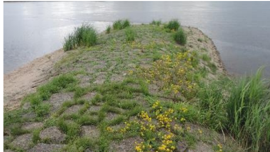
Foto 26: Die zur Sicherung der Schifffahrt eingebauten Buhnen ragen in die Strömung hinein, drängen diese vom Ufer weg und sorgen damit für die Freihaltung der Fahrrinne und gleichzeitig für Strömungsberuhigung in den Feldern zwischen den Buhnen. (Foto: STOWASSERPLAN)
