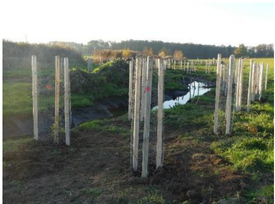
Foto 51: Einzelgehölzpflanzungen auf einem Uferstreifen sind aufwändiger in der Herstellung, insbesondere dann, wenn jedes Gehölz mit einem Verbissschutz versehen werden muss. (Foto: STOWASSERPLAN)
