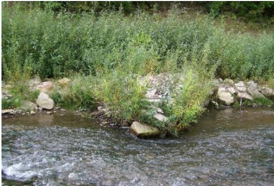
Foto 32: Links und rechts der Buhne erkennt man am strömungsbild, dass das Wasser kaum fließt und Ruhezonen entstehen. (Foto: STOWASSERPLAN)
