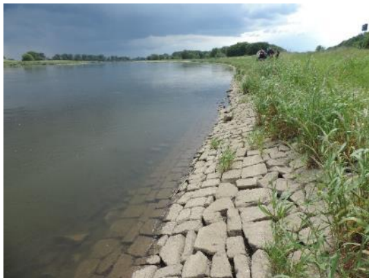
Foto 2: Je nach Zielvegetation kann die Ufersicherung aus Steinsatz auch durch einen Uferghölzsaum ersetzt werden (Foto: STOWASSERPLAN)
