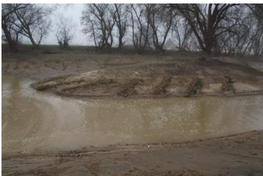
Foto 9: Lebendfaschinen sind eine lineare ingenieurbioologische Ufersicherung. Sie können uferparallel oder geneigt eingebaut werden. (Foto: STOWASSERPLAN)
