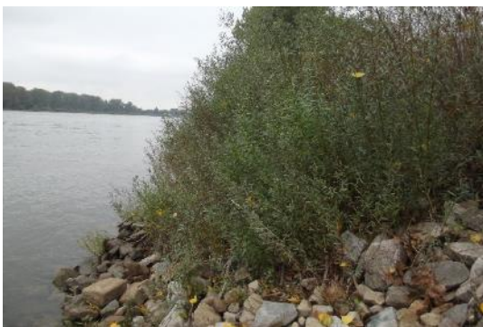
Foto 11: Aus den ingenieurb biologischen Bauweisen bildet sich schon nach kurzer Zeit ein dichter Uferweiden bzw. Gehölzbestand. (Foto: STOWASSERPLAN)
