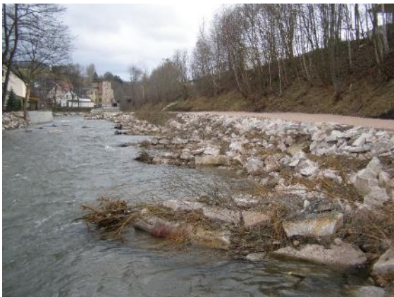
Foto 30: Diese Ufersicherung wurde mit begrünten Blockbuhnen kombiniert. (Foto: STOWASSERPLAN)
