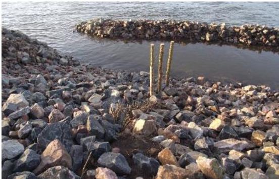
Foto 23: Das Längswerk aus Steinschüttung schafft unmittelbar einen strömungsberuhigten Bereich. Ergänzend dazu dienen Weidensetzstangen (Bildmitte) und Buschlagen (im Vordergrund des Bildes) dazu, durch die Vegetationsentwicklung eine weitere Strömungsberuhigung zu bewirken. (Foto: STOWASSERPLAN)
