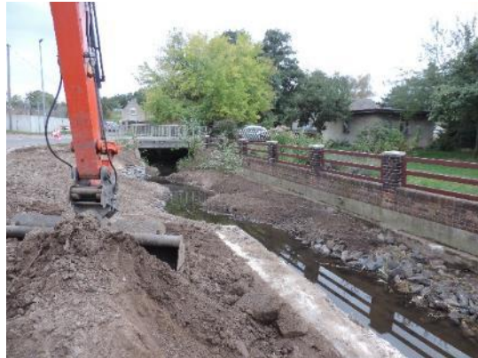
Foto 8: Zustand nach Fertigstellung des Teilerückbaus der Ufermauer und der Böschungsprofilierung (Foto: STOWASSERPLAN)
