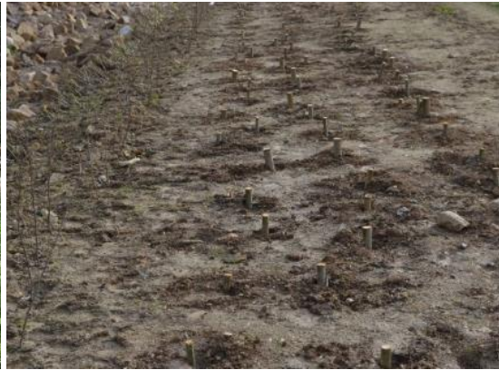
Foto 50: Durch ingenieurblogische Bauweisen lassen sich standortgerechte Vegetationsbestände auf einfache Weise etablieren. Hier werden Steckhölzer zur Ansiedlung von Gehölzbeständen genutzt. (Foto: STOWASSERPLAN)
