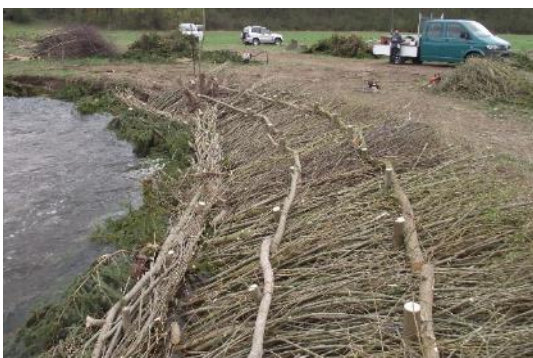
Foto 12: Spreitlagen sind eine sehr stabile und effektive ingenieurb biologische Bauweise. (Foto: STOWASSERPLAN)
