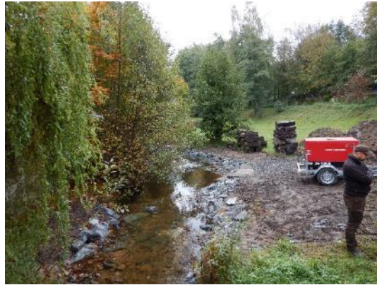
Foto 14: Zustand nach Fertigstellung, die Vegetationsdeckschicht wurde abgetragen und mittel Bagger eine Abflachung vorgenommen. Die weitere Ausbreitung des Gewässers wurde hier durch eine Steinschüttung unterbunden. (Foto: STOWASSERPLAN)
