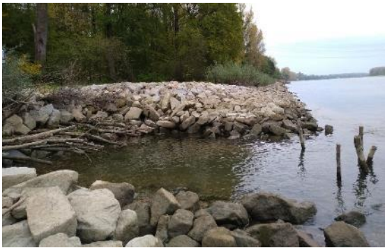
Foto 28: Einbau von Fischunterständen mit strömungsberuhigten Bereichen im Rahmen von Ufersanierungs- und Gestaltungsmaßnahmen. Der Einstrombereich wurde durch relativ eng stehende Weidensetzstangen markiert und von der Hauptströmung abgegrenzt. (Foto: STOWASSERPLAN)
