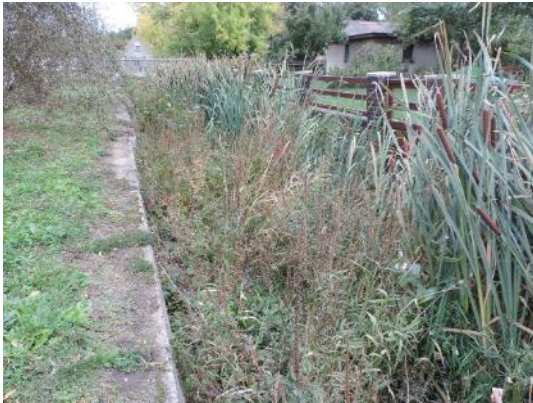
Foto 7: In diesem Beispiel wurde eine bereits verfallende Ufermauer partiell zurückgebaut und durch eine Aufweitung und Abflachung der Ufer ersetzt. (Foto: STOWASSERPLAN)
