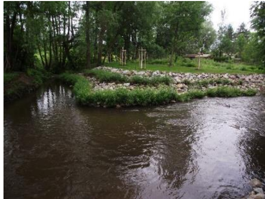
Foto 21: Nach Abschluss der Arbeiten kann sich der Wasserspiegel frei fließend einstellen. Die Begrünung sorgt für Beschattung des Gewässers und die Sicherung der Uferböschungen. (Foto: STOWASSERPLAN)
