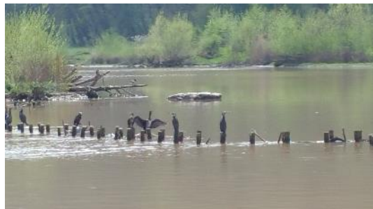
Foto 15: Pfahlbuhnen wirken ähnlich wie Totholzbuhnen sind aber von eingeschränkter Dauerhaftigkeit. (Foto: STOWASSERPLAN)
