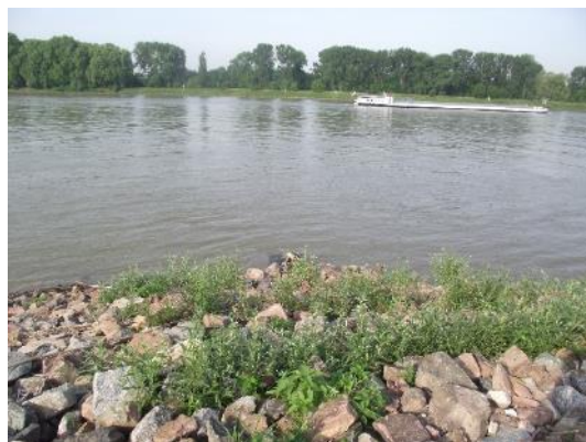
Foto 7: Erster Austrieb der Buschlagen an dieser Buhne (Foto: STOWASSERPLAN)
