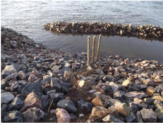
Foto 8: Geschüttetes Längswerk mit Buschlagen und Weidensetzstangen zu sehen. (Foto: STOWASSERPLAN)
