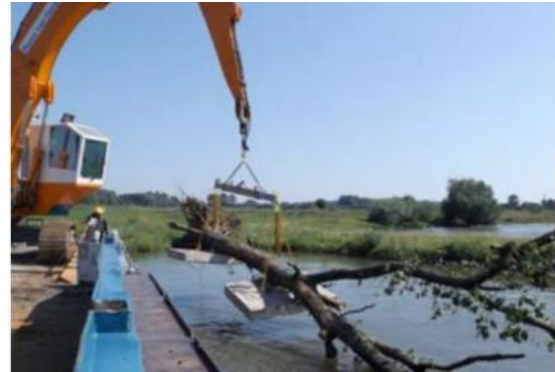
Foto 13: In breiten Gewässern kann auch ein ganzer Baum als Raubaum (hier mit Betonplatten gesichert und verankert) zur Strömungsdifferenzierung eingebaut werden (BUREAU WAARDENBURG EN GLOEDCOMMUNICATIE 2021)
