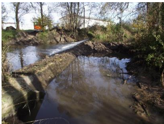
Foto 18: Beispielmaßnahme zum Rückbau eines Wehres zum Einstau eines Mühlgrabens (Foto: STOWASSERPLAN)
