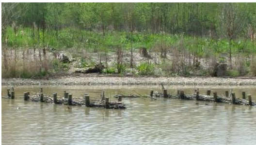
Foto 14: Alternative Buhnenformen sind Totholzbuhnen. Sie haben ein hohes Struktur- und Besiedlungspotential (Foto: STOWASSERPLAN)
