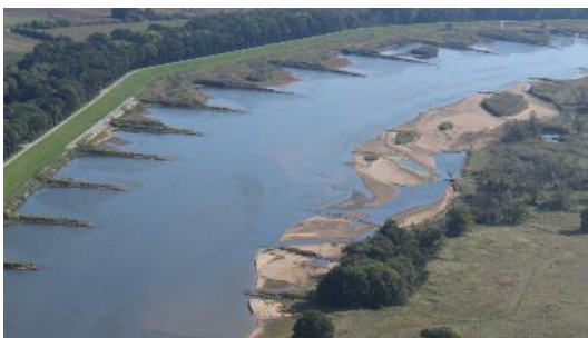
Foto 16: Zerstörte Regulierungsbauwerke am linken, deutschen Ufer der Oder bei Reitwein. Durch die Aufweitung des Durchflussquerschnitts kommt es zu Geschiebeablagerungen im Flussschlauch, wodurch die schiffahrtliche Nutzung der Oder gefährdet ist (Foto: WSA Oder-Havel)
