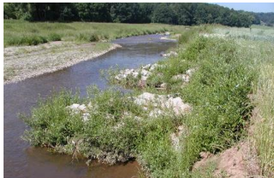
Foto 37: Begrünte Blockbuhne, Buhne aus gesetzten und geschütteten Lagen Wasserbausteinen mit einer Begrünung aus Buschlagen. Steinbuhnen bewirken auf Grund ihrer Massivität deutliche Veränderungen in der Strömung. Je nach Ausrichtung der Buhne (inklinant oder deklinant) werden Erosionen am Ufer und Kolkbildungen in der Gewässersohle ausgelöst. (Foto: STOWASSERPLAN)
