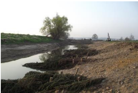
Foto 36: Raubbaum, ganze Kronen oder Kronenteile von Laub- oder Nadelgehölzen, die mit der Krone flussabwärts orientiert und in die Fließrichtung geneigt am Ufer befestigt werden. Die Bauweise drückt die Strömung vom Ufer weg und provoziert Erosionen am gegenüberliegenden Ufer. Im Strömungsschatten des Raubbaumes bilden sich Flachwasserbereiche und Anlandungen. (Foto: STOWASSERPLAN)
