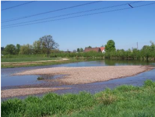
Foto 3: Das Geschiebemanagement sollte innerhalb des gleichen Gewässers erfolgen. Hier wurde vor der Ortslage ein Geschiebfang errichtet, um gezielt Substrat entnehmen und in der freien Landschaft wieder zugeben zu können. (Foto: STOWASSERPLAN)
