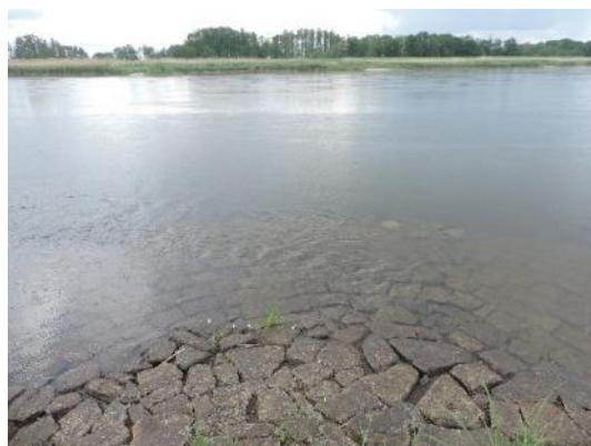
Foto 5: In die Strömung eintauchender Buhnenkopf (Foto: STOWASSERPLAN)
