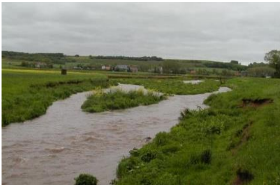
Foto 31: Durch ein Hochwasser wurde in diesem Gewässerabschnitt die Uferbefestigung herausgerissen. Durch Erosion der Ufer wurde das Querschnittsprofil ca. doppelt so breit. (Foto: STOWASSERPLAN)
