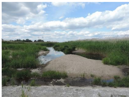
Foto 2: Substratzugaben sollten als Depotschüttung auf dem Ufer erfolgen, so dass sich das Gewässer die Substrate nach und nach mitnehmen kann. (Foto: STOWASSERPLAN)
