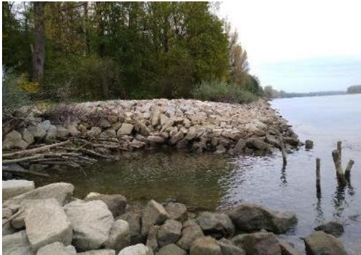
Foto 12: Strömungsberuhigter Bereich mit Fischunterstand - hier wurden eine Ausbuchtung in die Uferlinie gebaut (Foto: STOWASSERPLAN)
