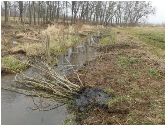
Foto 34: Lebender Abweiser, quer zur Fließrichtung eingebaute, austriebsfähige Äste, die sich zu einem dichten Weidengebüsch entwickeln. Die in den Stromstrich reichenden Äste bewirken Verwirbelungen mit Kolkbildungen sowie Strömungsberuhigungen im Randbereich. (Foto: STOWASSERPLAN)
