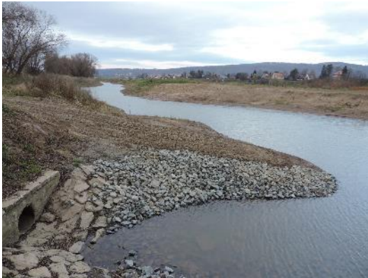
Foto 26: Freilegung eines historischen Altarmes der Elbe – zur Ufersicherung und -strukturierung sind ingenieurbio-ologische Bauweisen zum Einsatz gekommen (Foto: STOWASSERPLAN)
