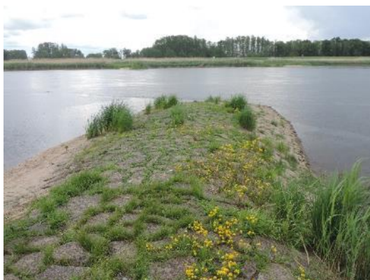
Foto 4: Zur Regulierung der Schifffahrt eingebaute senkrechte Buhne, ausgeführt als unbegrünter Steinsatz (Foto: STOWASSERPLAN)
