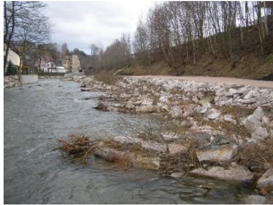
Foto 9: Auch eine Abfolge von Begrünten Blockbuhnen kann zur Strömungs- und Substratvielfalt beitragen. Wichtig ist dabei wiederum die Begrünung, da auch das Astwerk für Strukturvielfalt sorgt. (Foto: STOWASSERPLAN)
