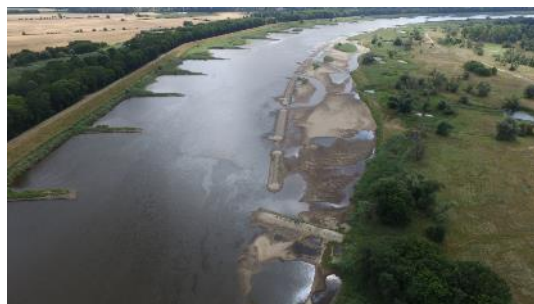
Foto 17: Im Auftrag der WSV von 2017 – 2019 errichtetes Längsbauwerk auf einer Länge von ca. 800 m im Bereich der zerstörten Buhnen an der Oder bei Reitwein. Die schiffahrtliche Nutzung ist nunmehr gewährleistet und die sich ausgebildeten Nebenrinnen und Uferstrukturen bleiben als wertvolle Biotope erhalten (Foto: WSA Oder-Havel)
