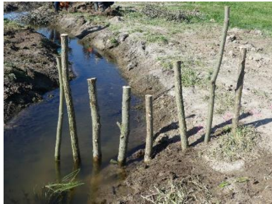
Foto 35: Rechenbuhne, Holzpfähle oder Weidensetzstangen werden als Reihe vom Ufer her bis in das Gewässer reichend quer zur Fließrichtung eingebaut. Derartige seitlich eingebaute Buhnen tragen zur Strömungsberuhigung in den Buhnenfeldern bei. Zwischen den Buhnen bilden sich Anlandungen. (Foto: STOWASSERPLAN)
