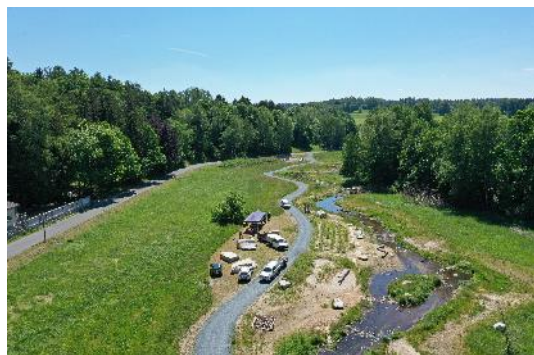
Foto 25: Wichtig ist die Modellierung eines naturnahen Profils, dann sind kaum Maßnahmen zur Ufersicherung erforderlich. (Foto: STOWASSERPLAN)
