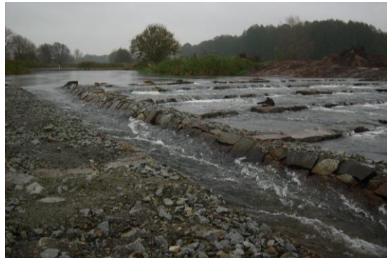
Foto 23: Bei ausreichender Wasserführung kann ein Kanupass die Durchgängigkeit für den muskelbetriebenen Schiffsverkehr sicherstellen. (Foto: Annett Marschall, LfU Brandenburg)
