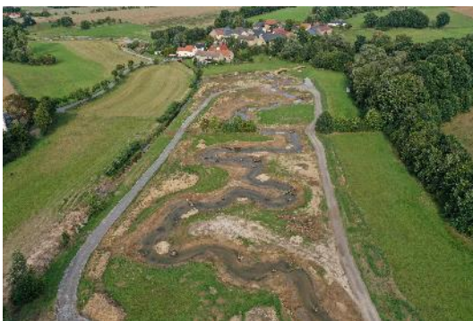
Foto 30: Nach den Erdarbeiten zur Profilmodellierung werden noch punktuell Abweiser, Faschinen, Setzstangen und Wurzelstubben zur Strukturierung eingebaut. (Foto: STOWASSERPLAN)
