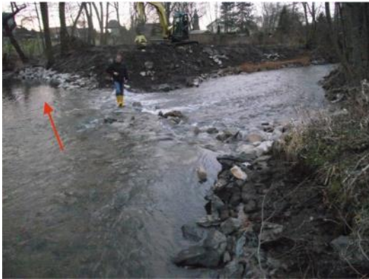
Foto 20: Das Wehr wurde vollständig zurückgebaut. Ufersicherungen erfolgten als mit Weiden begrünte Steinschüttung. (Foto: STOWASSERPLAN)
