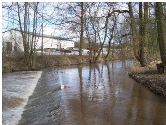
Foto 19: Die Bauwerkshöhe beträgt ca. 0,5 m. Es besteht keine ökologische Durchgängigkeit. (Foto: STOWASSERPLAN)
