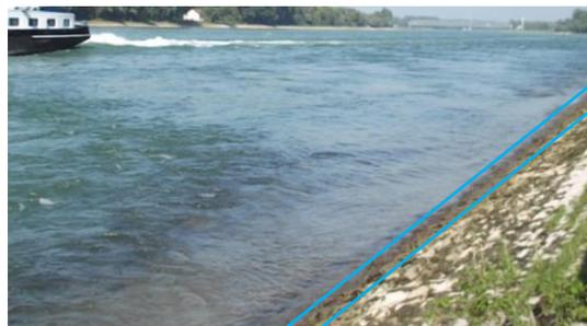
Foto 13: Vor dem Schiff entsteht ein Sog, der zu einer Wasserspiegelabsenkung führt (blaue Linien). Nach dem Schiff folgt der Schwall, der wellenartig auf das Ufer trifft.
