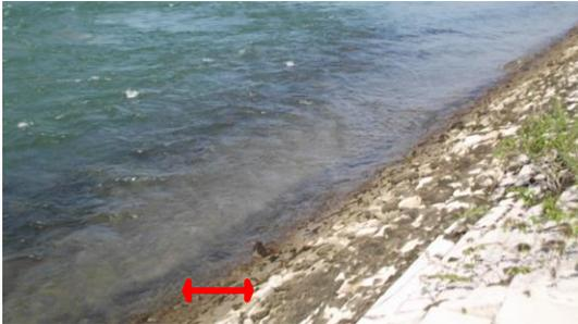
Foto 14: Sog und Schwall gehen mit hohen Schleppspannungen einher (Bereich roter Pfeil) und erfordern zur Gewährleistung der Schiffbarkeit daher meist eine Ufer- und Sohlensicherung. (Foto: STOWASSERPLAN)
