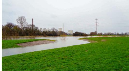
Foto 12: Südliche Flutrinne nach Maßnahmenumsetzung. Bei einem Wasserabfluss etwas oberhalb von Mittelwasser strömt das Wasser der Weser durch den geschaffenen Anschluss in die Flutrinnen. (Quelle: WSV, März 2019)
