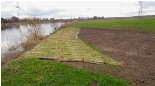
Foto 13: Einbau von Erosionsschutzmatten zum Schutz des Anschlussgrabens vor rückschreitender Erosion. (Quelle: WSV, Januar 2019)
