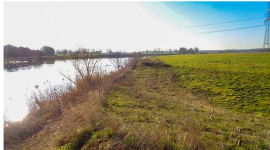
Foto 14: Das angewachsene Saatgut stabilisiert die Erosionsschutzmatten, die innerhalb von wenigen Jahren vollständig verrotten. (Quelle: WSV, Januar 2020)
