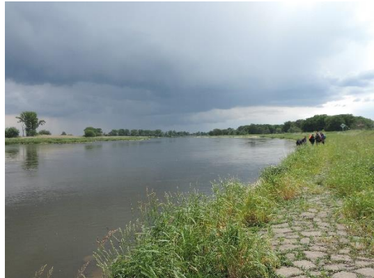
Foto 4: Blick auf Uferbefestigung aus Steinsatz, in den Fugen entwickeln sich bereits Uferstauden (Foto: STOWASSERPLAN)
