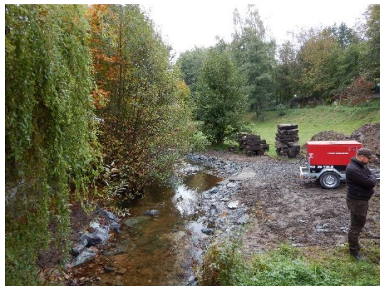
Foto 14: Zustand nach Fertigstellung, die Vegetationsdeckschicht wurde abgetragen und mittel Bagger eine Abflachung vorgenommen. Die weitere Ausbreitung des
