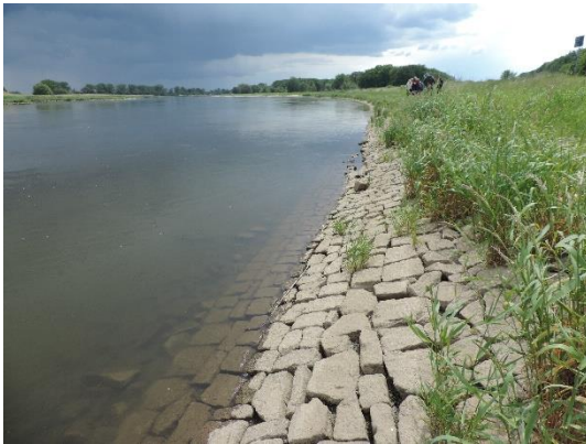
Foto 1: Blick auf eine Uferbefestigung aus Steinsatz. (Foto: STOWASSERPLAN)
