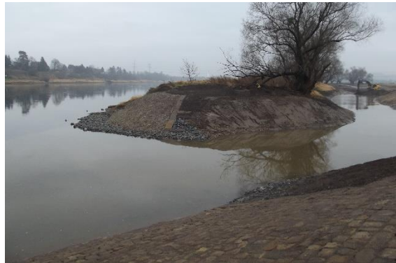
Foto 35: Der in der Vergangenheit verfüllte Elbseitenarm wurde wieder komplett freigelegt, aber nur im Bereich des Auslaufes mit dem Hauptstrom Elbe verbunden. Der Seitenarm füllt sich erst ab einer bestimmten Wasserspiegelhöhe mit Wasser. (Foto: STOWASSERPLAN)
