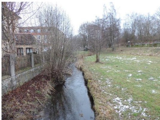
Foto 13: Ausgangszustand eines im Rahmen der Gewässerunterhaltung aufgeweiteten Gewässerabschnittes (Foto: STOWASSERPLAN)
