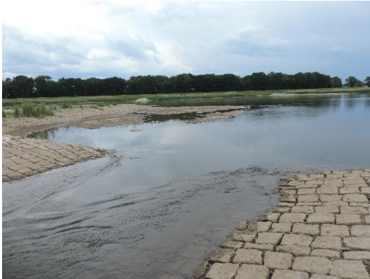
Foto 21: Einlaufbereich an einem aus Steinsatz errichteten Längswerk. (Foto: STOWASSERPLAN)
