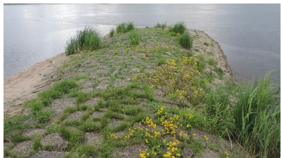
Foto 26: Die zur Sicherung der Schifffahrt eingebauten Buhnen ragen in die Strömung hinein, drängen diese vom Ufer weg und sorgen damit für die Freihaltung der Fahrinne und gleichzeitig für Strömungsberuhigung in den Feldern zwischen den Buhnen. (Foto: STOWASSERPLAN)
