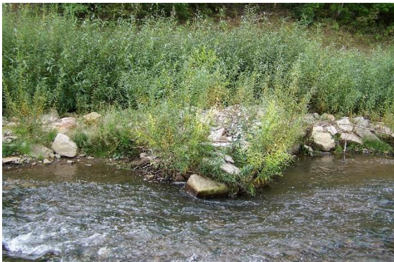
Foto 32: Links und rechts der Buhne erkennt man am Strömungsbild, dass das Wasser kaum fließt und Ruhezone entstehen. (Foto: STOWASSERPLAN)
