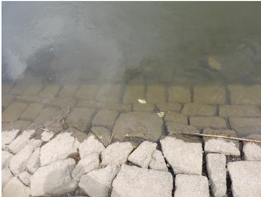
Foto 3: Strukturarme Ufersicherung aus Steinsatz (Foto: STOWASSERPLAN)
