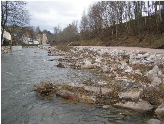
Foto 30: Diese Ufersicherung wurde mit begrüneten Blockbuhnen kombiniert. (Foto: STOWASSERPLAN)
