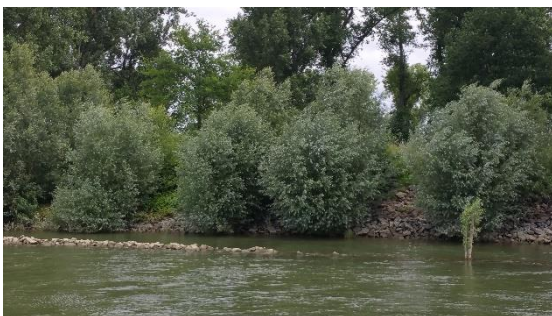
Foto 25: Die Kombination von längsgerichteten und quer zur Strömung ausgerichteten Elementen (aus Setzstangen und Buschlagen entwickelte Gehölzstreifen) sind bei größeren Gewässern und höheren Wasserspiegelschwankung besonders effektiv zur Strömungsberuhigung. (Foto: STOWASSERPLAN)
