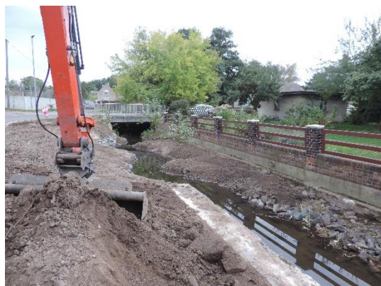
Foto 6: Bei bestehenden Steinschüttungen können durch Aufbrechen einer Riefe und Einbau einer Begrünung mit Setzstangen oder Heck- bzw. Buschlagen standorttypische, das Ufer stabilisierende Arten eingebracht werden. (Foto: STOWASSERPLAN)
