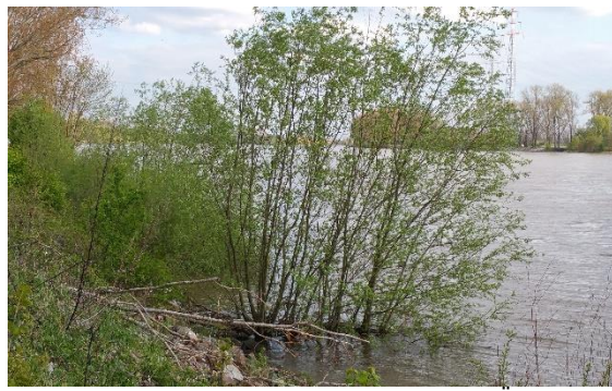
Foto 24: Bei höheren Wasserspiegellagen mit Überströmung des Längswerkes bremsen die streifenartig angelegten und in den Abfluss hinein ragenden Ufergehölze (Austrieb aus den Setzstangen) die Strömung. (Foto: STOWASSERPLAN)
