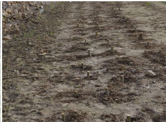
Foto 50: Durch ingenieurbiologische Bauweisen lassen sich standortgerechte Vegetationsbestände auf einfache Weise etablieren. Hier werden Steckhölzer zur Ansiedlung von Gehölzbeständen genutzt. (Foto: STOWASSERPLAN)
