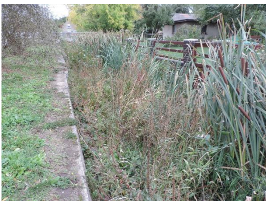
Foto 5: Ufersicherung aus Steinschüttung - die Natur versucht auch von sich aus solche Ufer zu begrünen. Doch die aufkommenden Arten sind nicht immer zur Sicherung eines Gewässerufers geeignet. (Foto: STOWASSERPLAN)
