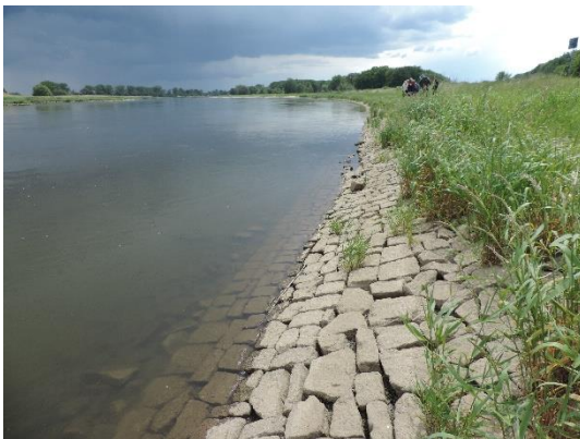
Foto 2: Je nach Zielvegetation kann die Ufersicherung aus Steinsatz auch durch einen Uferhölzsaum ersetzt werden (Foto: STOWASSERPLAN)
