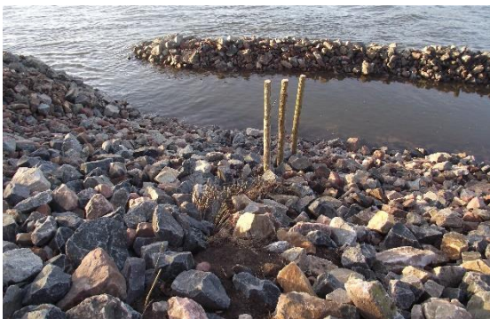
Foto 23: Das Längswerk aus Steinschüttung schafft unmittelbar einen strömungsberuhigten Bereich. Ergänzend dazu dienen Weidensetzstengen (Bildmitte) und Buschlagen (im Vordergrund des Bildes) dazu, durch die Vegetationsentwicklung eine weitere Strömungsberuhigung zu bewirken. (Foto: STOWASSERPLAN)
