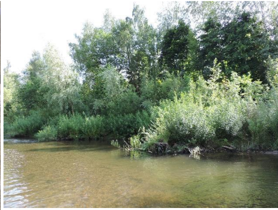
Foto 31: Die Buhnen drängen die Hauptströmung weg vom Ufer und zwischen den Buhnen entstehen ruhige Flachwasserbereiche. (Foto: STOWASSERPLAN)
