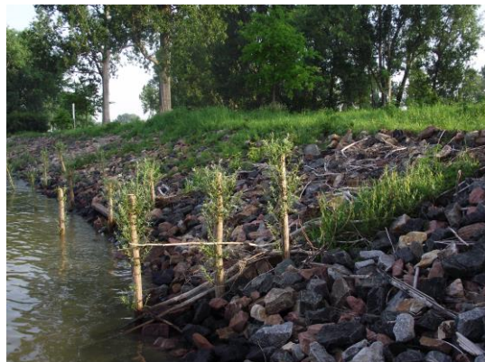
Foto 6: Bei bestehenden Steinschüttungen können durch Aufbrechen einer Riefe und Einbau einer Begrünung mit Setzstangen oder Heck- bzw. Buschlagen standorttypische, das Ufer stabilisierende Arten eingebracht werden. (Foto: STOWASSERPLAN)
