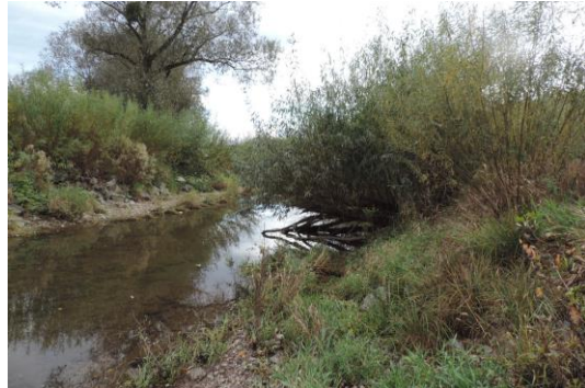
Foto 37: Aus den Buschlagen und Lebenden Abweisern am Auslauf hat sich ein Uferweidengebüsch entwickelt. Es trägt zur Strukturierung und Initiierung von Eigendynamik bei. (Foto: STOWASSERPLAN)
