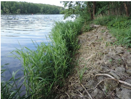
Foto 5: Ufersicherung aus Steinschüttung - die Natur versucht auch von sich aus solche Ufer zu begrünen. Doch die aufkommenden Arten sind nicht immer zur Sicherung eines Gewässerufers geeignet. (Foto: STOWASSERPLAN)
