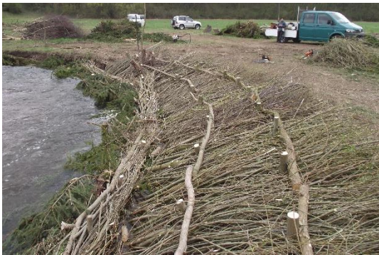
Foto 12: Spreitlagen sind eine sehr stabile und effektive ingenieurbiologische Bauweise. (Foto: STOWASSERPLAN)
