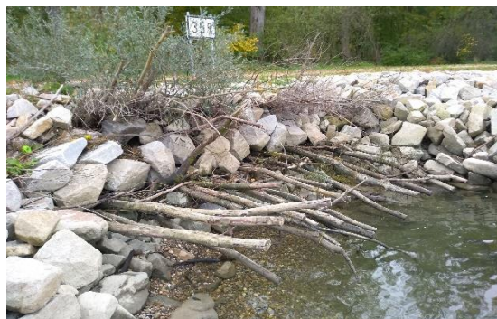
Foto 29: Die buchtenartigen Taschen in der Ufersicherung wurden mit lebendem Astwerk und Buschlagen begrünt. (Foto: STOWASSERPLAN)
