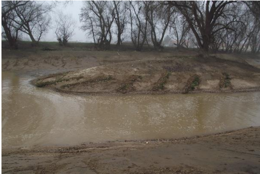
Foto 9: Lebendfaschinen sind eine lineare ingenieurbio- logische Ufersicherung. Sie können uferparallel oder ge- neigt eingebaut werden. (Foto: STOWASSERPLAN)
