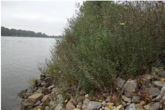
Foto 11: Aus den ingenieurbio- logischen Bauweisen bil- det sich schon nach kurzer Zeit ein dichter Uferweiden bzw. Gehölzbestand. (Foto: STOWASSERPLAN)
