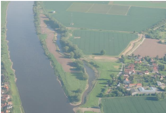
Foto 34: Wiederherstellung eines Elbseitenarmes, Luftaufnahme kurz nach Baufertigstellung (Foto: STOWASSERPLAN)
