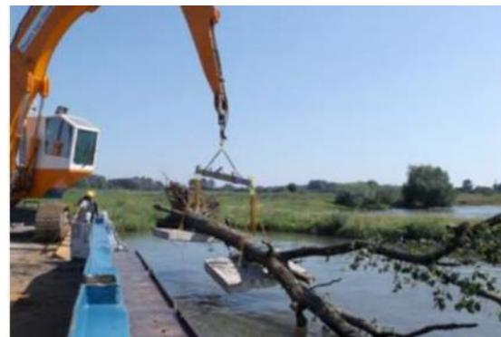
Foto 17: In breiten Gewässern kann auch ein ganzer Baum als Raubaum (hier mit Betonplatten gesichert und verankert) zur Strömungsdifferenzierung eingebaut werden (BUREAU WAARDENBURG EN GLOEDCOMMUNICATIE 2021)
