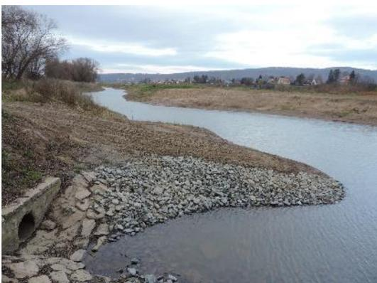
Foto 28: Freilegung eines historischen Altarmes der Elbe – zur Ufersicherung und -strukturierung sind ingenieurbioologische Bauweisen zum Einsatz gekommen (Foto: STOWASSERPLAN)
