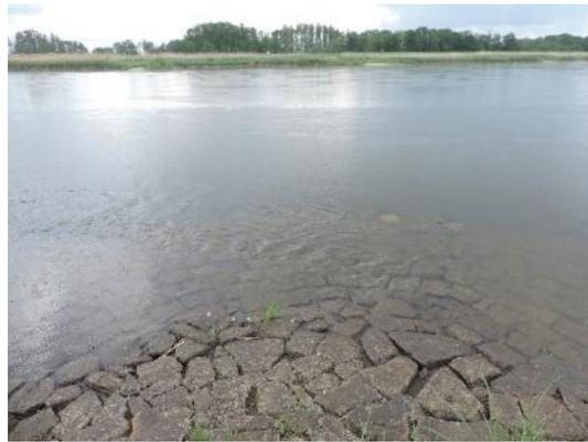
Foto 9: In die Strömung eintauchender Bühnenkopf (Foto: STOWASSERPLAN)
