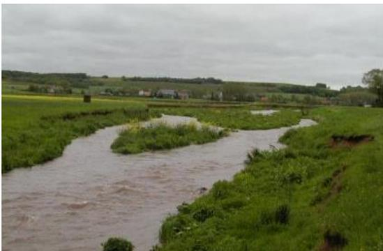
Foto 33: Durch ein Hochwasser wurde in diesem Gewässerabschnitt die Uferbefestigung herausgerissen. Durch Erosion der Ufer wurde das Querprofil ca. doppelt so breit. (Foto: STOWASSERPLAN)
