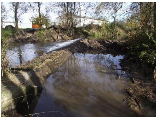
Foto 22: Beispielmaßnahme zum Rückbau eines Wehres zum Einstau eines Mühlgrabens (Foto: STOWASSERPLAN)
