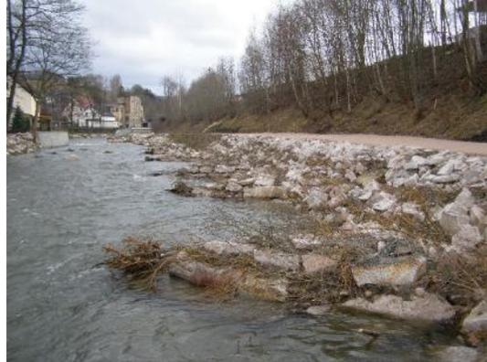
Foto 13: Auch eine Abfolge von Begrünten Blockbuhnen kann zur Strömungs- und Substratvielfalt beitragen. Wichtig ist dabei wiederum die Begrünung, da auch das Astwerk für Strukturvielfalt sorgt. (Foto: STOWASSERPLAN)
