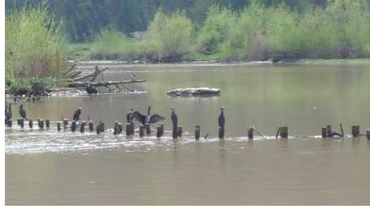
Foto 19: Pfahlbuhnen wirken ähnlich wie Totholzbuhnen sind aber von eingeschränkter Dauerhaftigkeit. (Foto: STOWASSERPLAN)
