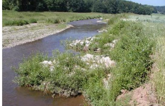
Foto 39: Begrünte Blockbuhne, Buhne aus gesetzten und geschütteten Lagen Wasserbausteinen mit einer Begrünung aus Buschlagen. Steinbuhnen bewirken auf Grund ihrer Massivität deutliche Veränderungen in der Strömung. Je nach Ausrichtung der Buhne (inklinant oder deklinant) werden Erosionen am Ufer und Kolkbildungen in der Gewässersohle ausgelöst. (Foto: STOWASSERPLAN)
