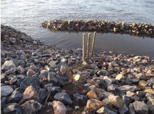
Foto 12: Geschüttetes Längswerk mit Buschlagen und Weidensetzstangen zu sehen. (Foto: STOWASSERPLAN)
