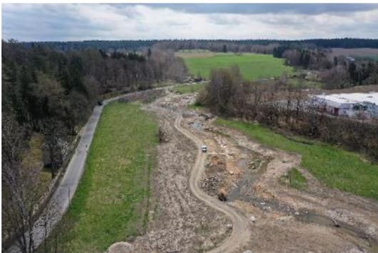
Foto 26: Maßnahmen zur Laufveränderungen erfordern eine ausreichende Flächenverfügbarkeit. (Foto: STOWASSERPLAN)
