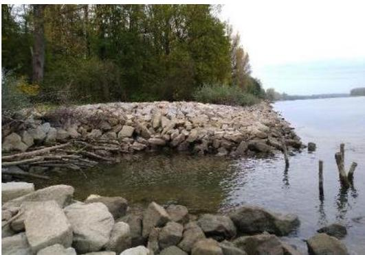
Foto 16: Strömungsberuhigter Bereich mit Fischunterstand - hier wurden eine Ausbuchtung in die Uferlinie gebaut (Foto: STOWASSERPLAN)
