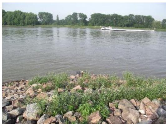
Foto 11: Erster Austrieb der Buschlagen an dieser Buhne (Foto: STOWASSERPLAN)
