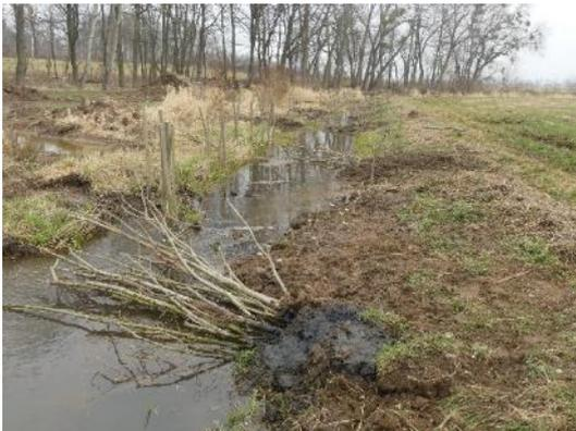
Foto 36: Lebender Abweiser, quer zur Fließrichtung eingebaute, austriebsfähige Äste, die sich zu einem dichten Weidengebüsch entwickeln. Die in den Stromstrich reichenden Äste bewirken Verwirbelungen mit Kolkbildungen sowie Strömungsberuhigungen im Randbereich. (Foto: STOWASSERPLAN)
