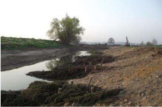
Foto 38: Raubaum, ganze Kronen oder Kronenteile von Laub- oder Nadelgehölzen, die mit der Krone flussabwärts orientiert und in die Fließrichtung geneigt am Ufer befestigt werden. Die Bauweise drückt die Strömung vom Ufer weg und provoziert Erosionen am gegenüberliegenden Ufer. Im Strömungsschatten des Raubaumes bilden sich Flachwasserbereiche und Anlandungen. (Foto: STOWASSERPLAN)
