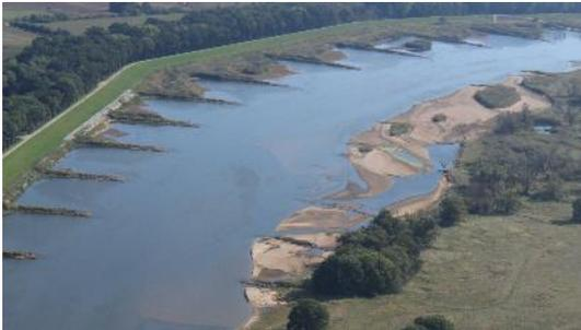
Foto 20: Zerstörte Regulierungsbauwerke am linken, deutschen Ufer der Oder bei Reitwein. Durch die Aufweitung des Durchflussquerschnitts kommt es zu Geschiebeablagerungen im Flussschlauch, wodurch die schiffahrtliche Nutzung der Oder gefährdet ist (Foto: WSA Oder-Havel)
