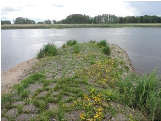
Foto 8: Zur Regulierung der Schifffahrt eingebaute senkrechte Bühne, ausgeführt als unbegrünte Steinsatz (Foto: STOWASSERPLAN)
