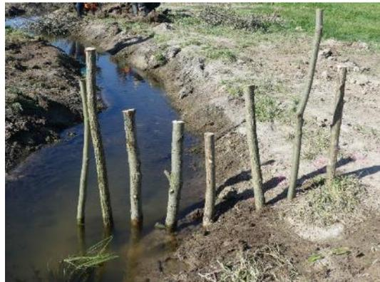
Foto 37: Rechenbuhne, Holzpfähle oder Weidensetzstangen werden als Reihe vom Ufer her bis in das Gewässer reichend quer zur Fließrichtung eingebaut. Derartige seitlich eingebaute Buhnen tragen zur Strömungsberuhigung in den Buhnenfeldern bei. Zwischen den Buhnen bilden sich Anlandungen. (Foto: STOWASSERPLAN)
