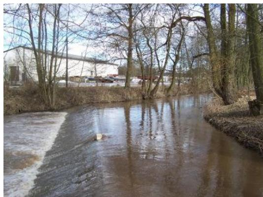
Foto 23: Die Bauwerkshöhe beträgt ca. 0,5 m. Es besteht keine ökologische Durchgängigkeit. (Foto: STOWASSERPLAN)
