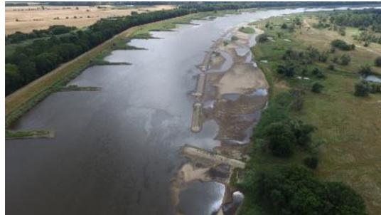
Foto 21: Im Auftrag der WSV von 2017 – 2019 errichtetes Längsbauwerk auf einer Länge von ca. 800 m im Bereich der zerstörten Buhnen an der Oder bei Reitwein. Die schiffahrtliche Nutzung ist nunmehr gewährleistet und die sich ausgebildeten Nebenrinnen und Uferstrukturen bleiben als wertvolle Biotope erhalten (Foto: WSA Oder-Havel)
