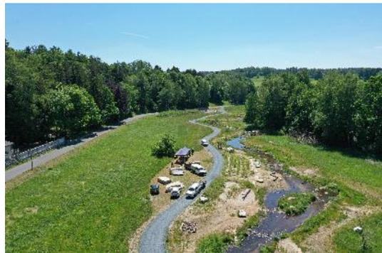
Foto 27: Wichtig ist die Modellierung eines naturnahen Profils, dann sind kaum Maßnahmen zur Ufersicherung erforderlich. (Foto: STOWASSERPLAN)
