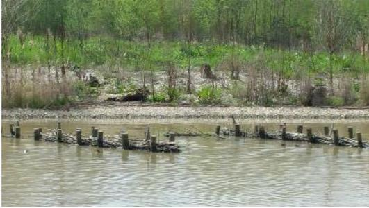
Foto 18: Alternative Buhnenformen sind Totholzbuhnen. Sie haben ein hohes Struktur- und Besiedlungspotential (Foto: STOWASSERPLAN)
