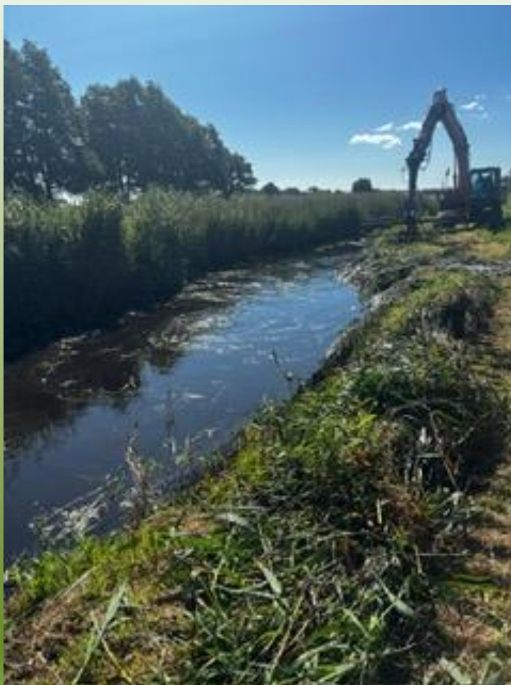
Situation während der Unterhaltungsarbeiten – Unterstützung von Land mit Kettenbagger und Mähkorb
