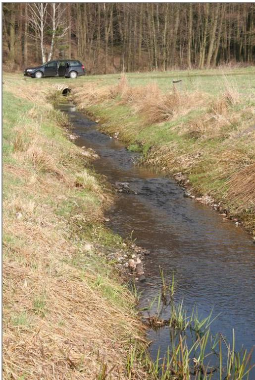
Abbildung 7-16: Sohlsicherung an einer geöffneten Verrohrung in Form einer Rausche – Kolk – Gestaltung aus Kiessubstrat
