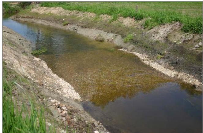
Abbildung 7-17: Kiesriffle (Bauzustand)
