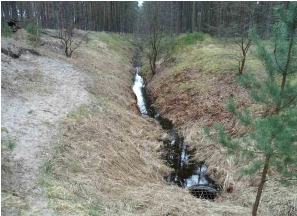
Abbildung 5: Lotzingraben oberhalb der Komplettverrohrung
