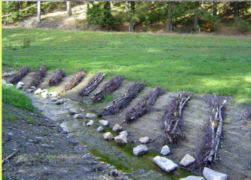
Detail Schrägfaschinen mit Kokosnetz zur Anfangssicherung
