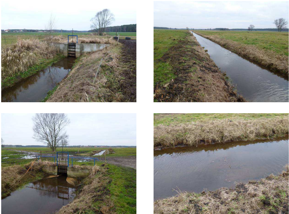
Abb. 19: Dammühlenfließ Fotos Planungsabschnitt DMF_P 08
