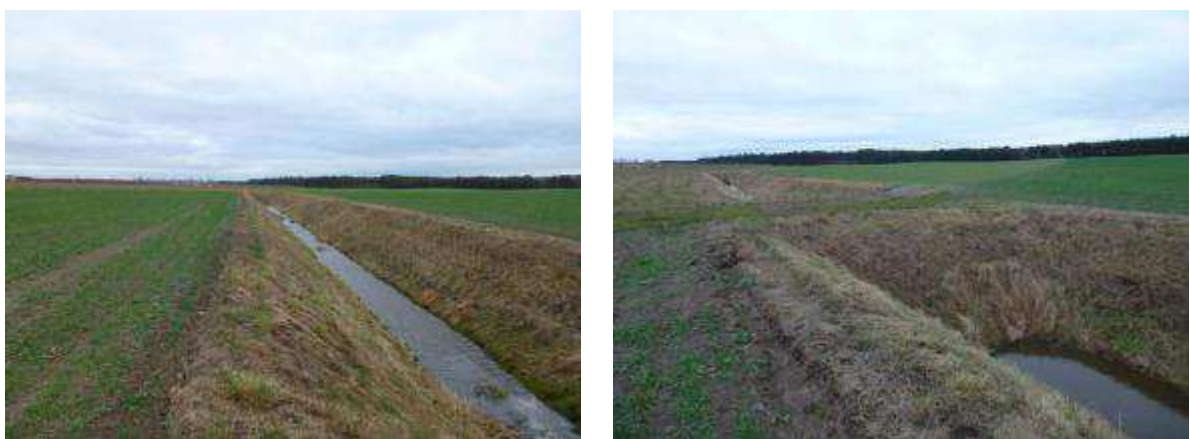
Abb. 33: Dammühlenfließ Fotos Planungsabschnitt DMF_P 15
