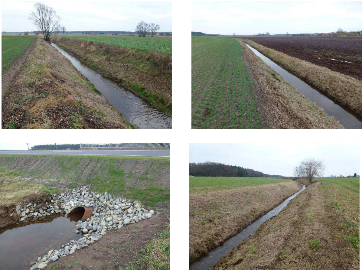
Abb. 17: Dammühlenfließ Fotos Planungsabschnitt DMF_P 07
