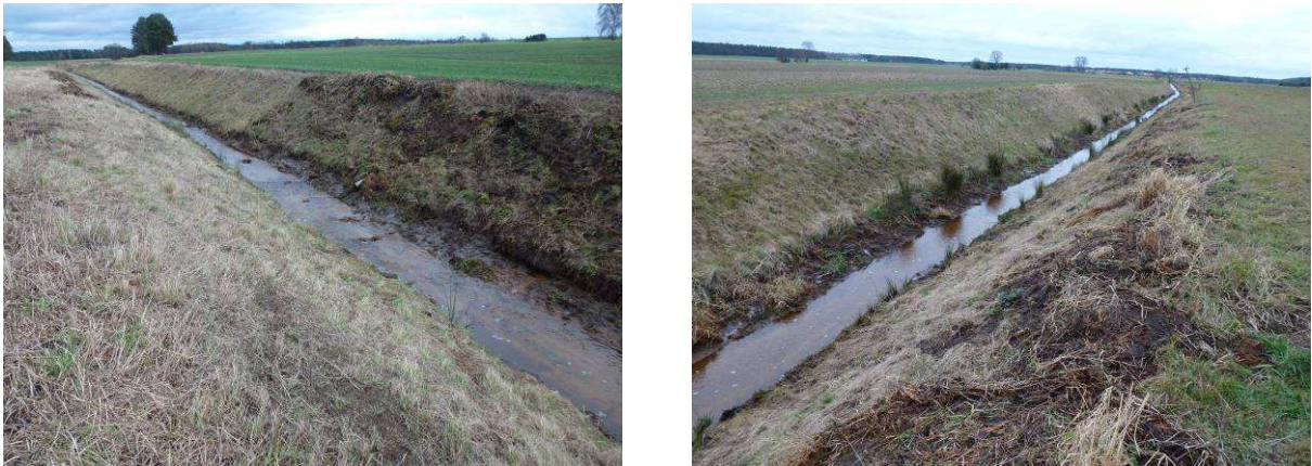
Abb. 21: Dammühlenfließ Fotos Planungsabschnitt DMF_P 09
