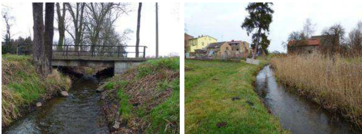
Abb. 9: Dammühlenfließ Fotos Planungsabschnitt DMF_P 03
