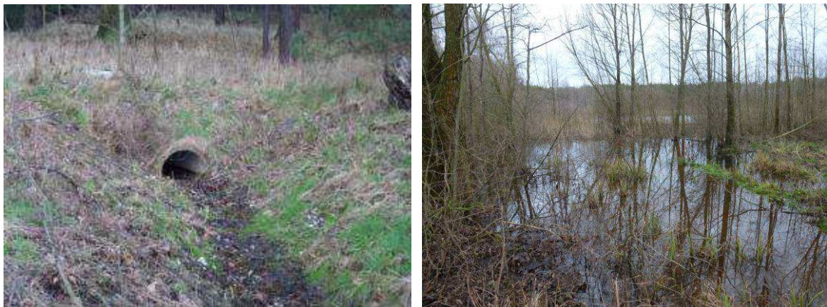
Abb. 25: Dammühlenfließ Fotos Planungsabschnitt DMF_P 11
