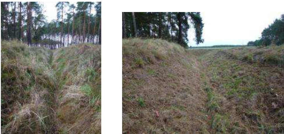
Abb. 31: Dammühlenfließ Fotos Planungsabschnitt DMF_P 14
