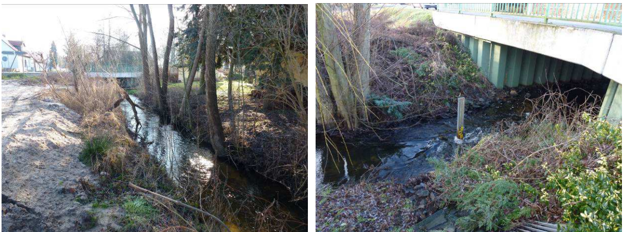
Abb. 69: Pieskower Torfgraben Fotos Planungsabschnitt PTG_P 03
