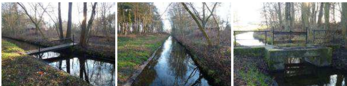
Abb. 65: Pieskower Torfgraben Fotos Planungsabschnitt PTG_P 01
