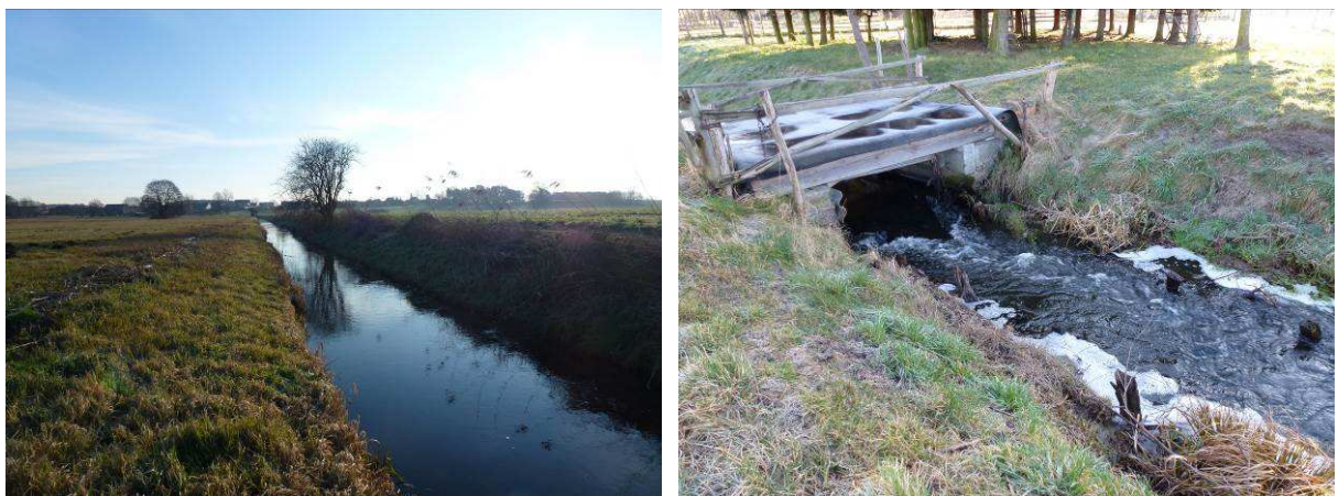
Abb. 67: Pieskower Torfgraben Fotos Planungsabschnitt PTG_P 02
