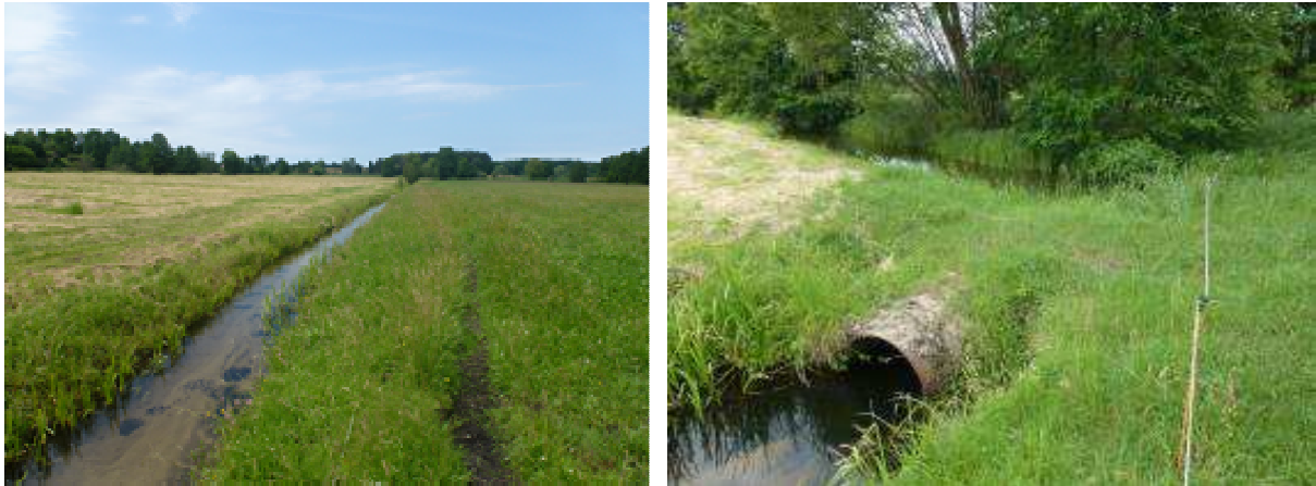
Abb. 53: Blasdorfer Quellmoorgraben Fotos Planungsabschnitt BQG_P 01
