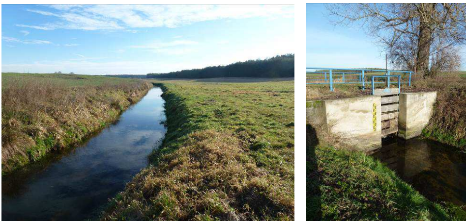
Abb. 71: Pieskower Torfgraben Fotos Planungsabschnitt PTG_P 04
