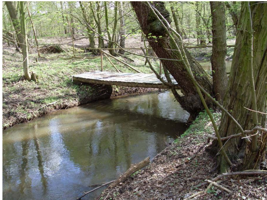
Abbildung 2-3: Möglicherweise überströmte Holzbrücke am km 47,18
