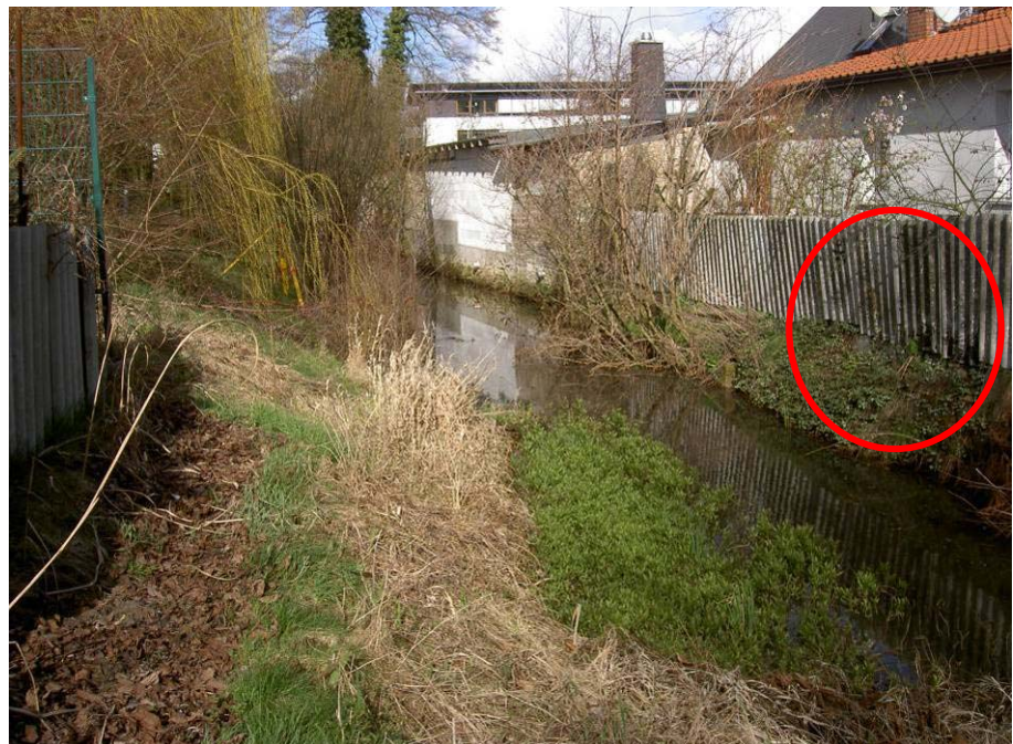
Abbildung 4-11: Problembereich G entlang der Stadtnuthe, Profil an der Stationierung 41267,51 (Foto: VPT, 2008)
