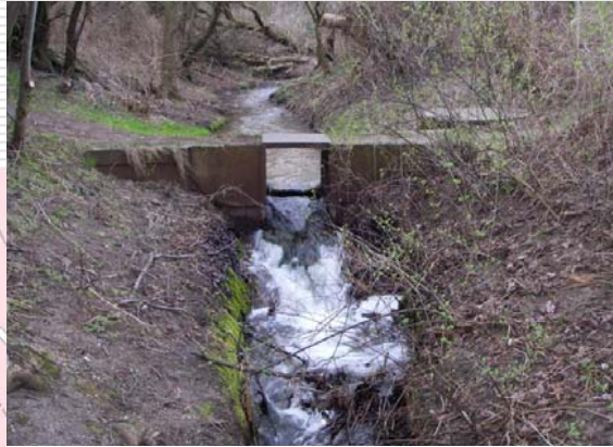
Wehr mit Absturztreppe ersetzen durch raue Sohleite
