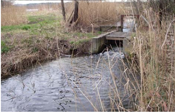
Wehr mit Absturztreppe ersetzen durch raue Sohleite
