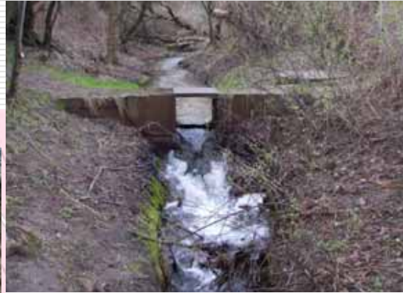
Wehr mit Absturztreppe ersetzen durch raue Sohlgleite
