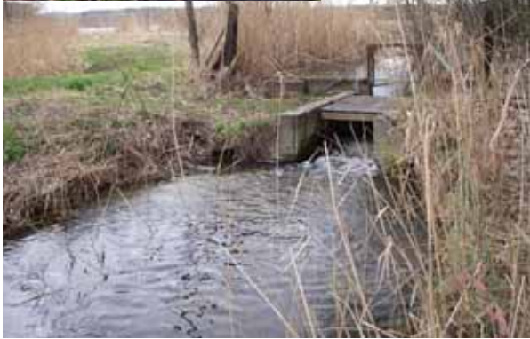
Wehr mit Absturztreppe ersetzen durch raue Sohlgleite
