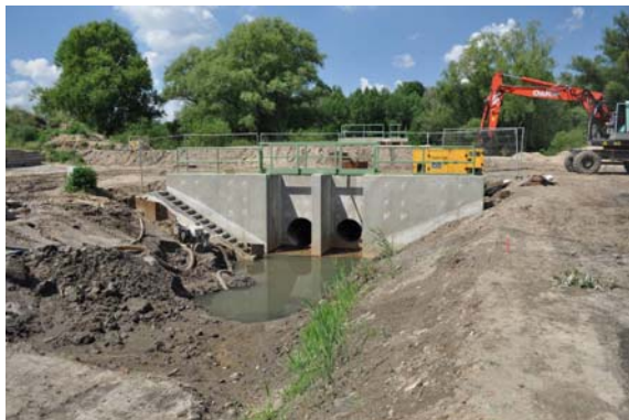
Abbildung 13: Pottacksiel (Baumaßnahmen, Juli 2011)
