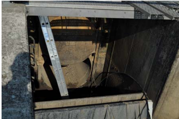
Abbildung 12: Freiauslass am Schöpfwerk (Baumaßnahmen, Juli 2011)
