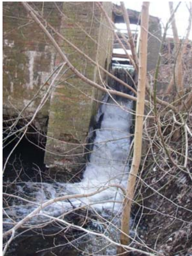
Abbildung 96: Klixmühle im Abschnitt BAS_04
