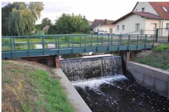
Abbildung 95: Wehr oberhalb Schleuse Brieskow
