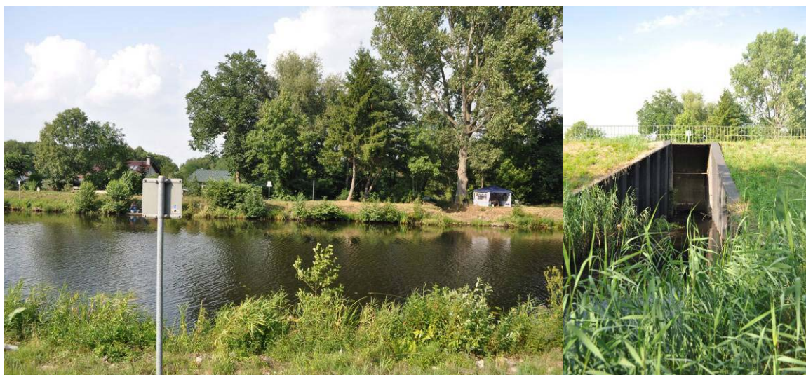
Abbildung 6: Düker der alten Schlaube durch den Oder-Spree-Kanal
