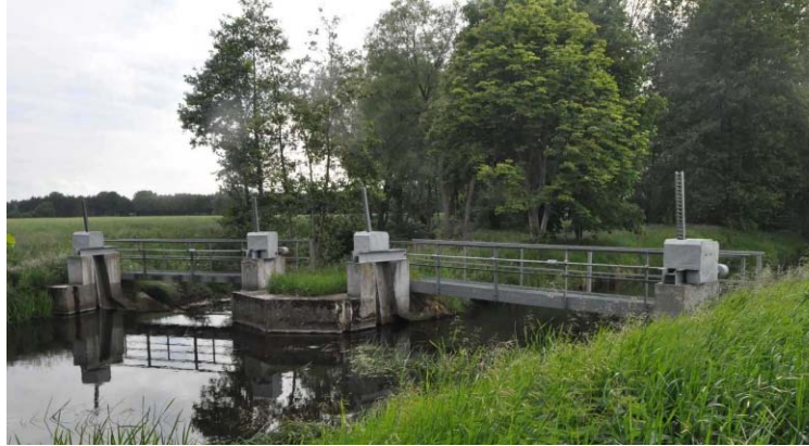
Verteilerwehr bei Plänitz „Mittlere“, Alte und „Neue“ Jäglitz
