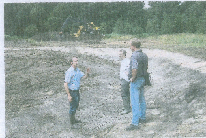
Wilfried Döscher, Thomas Garz und Bauleiter Peter Hinzmann (von links) auf der Baustelle im Becketal. FOTO: TOBIAS DOHR
