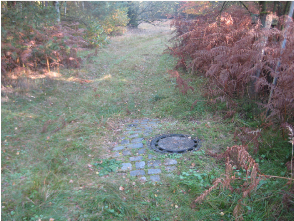
Abbildung 6-2: Trasse des Zuleiters mit Hydrant der Rohwasserleitung
