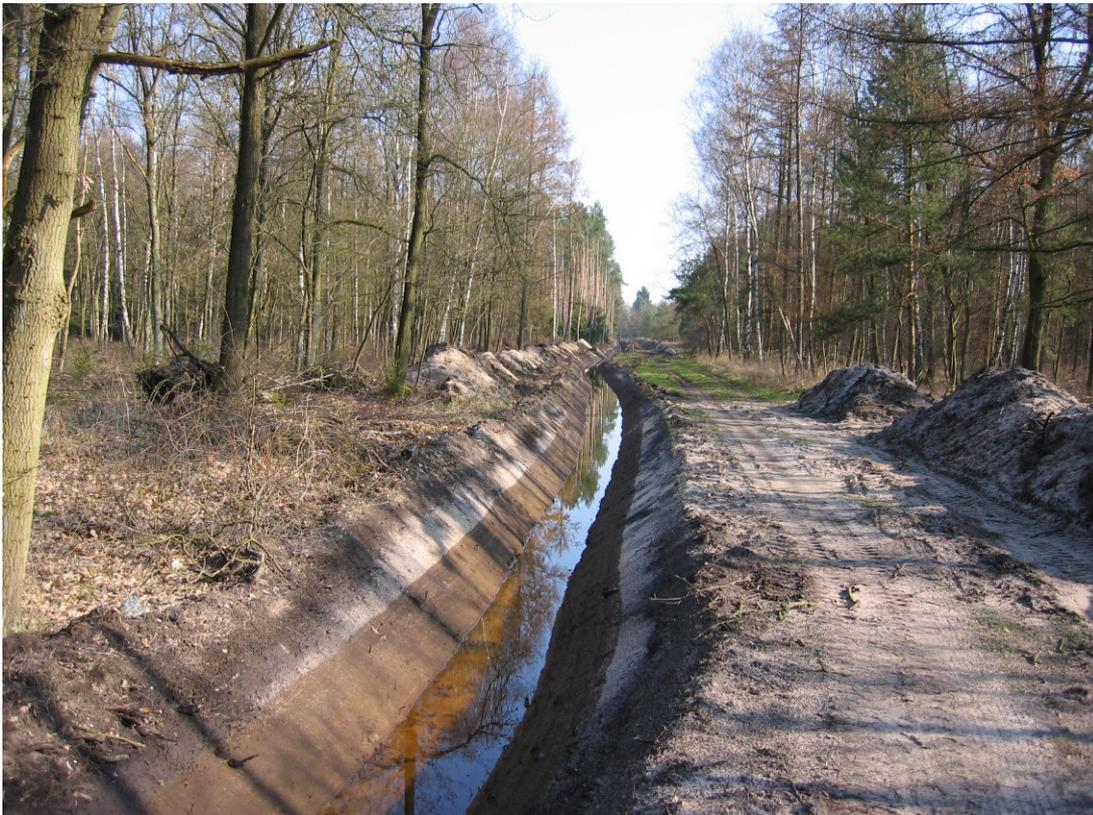
Abbildung 4-10: Ablagerung von feinstem Bodenmaterial an den Böschungen des Zuleiters (ca. 150 m nach der Entnahmestelle) unmittelbar nach Beendigung des Feldversuchs
