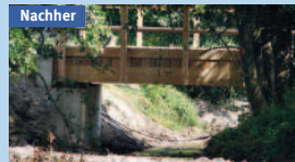
Brücke 2 nach Neuerstellung
